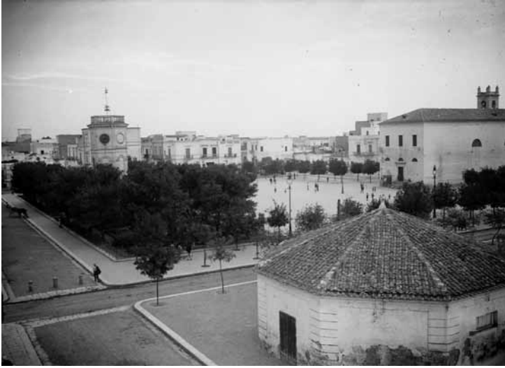
Fig. 4 – Piazza della Costituzione, circa anni '30 del XX secolo. In primo piano l'edificio ottagonale del centimolo (mulino) e gli alberetti dei lecci da poco piantumati. A destra la sacrestia della chiesa matrice ferdinandea. Notare anche i pali della pubblica illuminazione.
